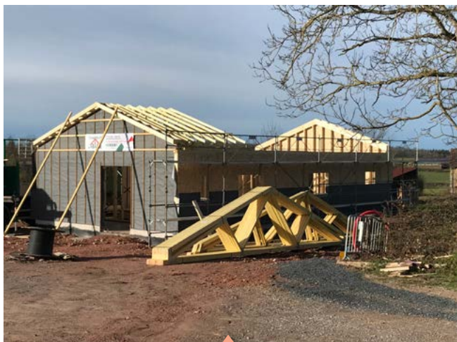
Pose de l'ossature et charpente
